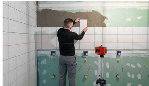
Der FLOX verfügt über ein 1/4" und 5/8" Gewinde und kann so problemlos auf einem Stativ befestigt werden. Dadurch kann das nivellierte Wandkreuz genutzt werden, um Fliesen auch an der Wand anzubringen.
